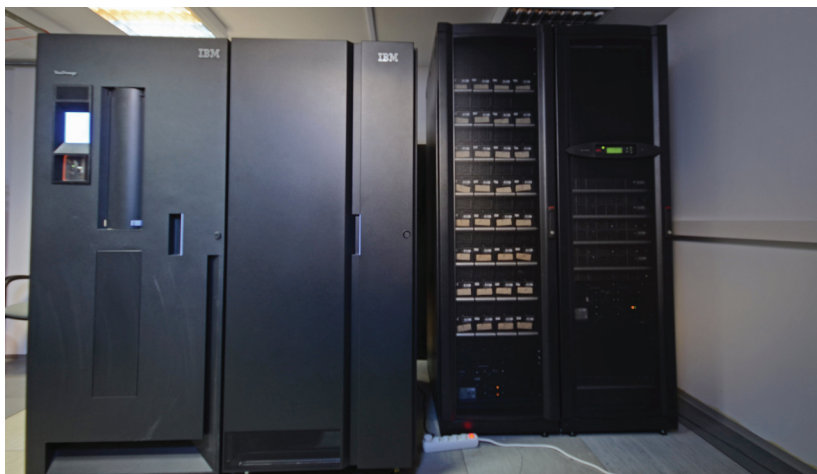
A projekt keretében bővített szalagos archiváló rendszer (balra) és folyamatos működését biztosító szünetmentes tápegység
