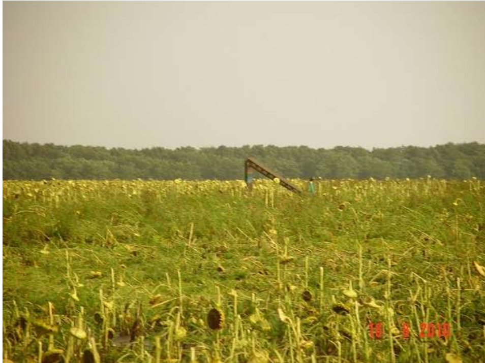
10. ábra: A tornádó a beton villanyoszlopot kettétörte (forrás: szupercella.hu, devin2)
